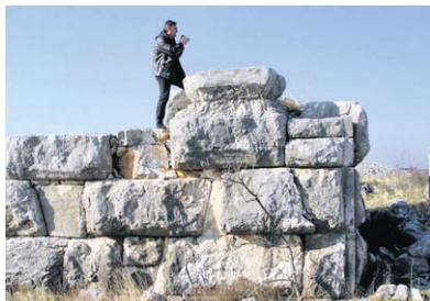
Ciklopski slog kamenih gromada građen bez vezivnog materijala.
